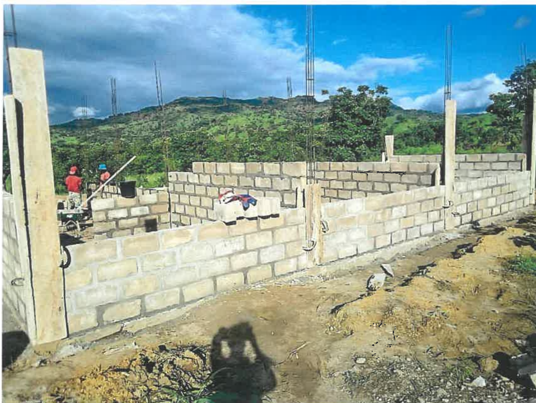
POLLAIO IN COSTRUZIONE
