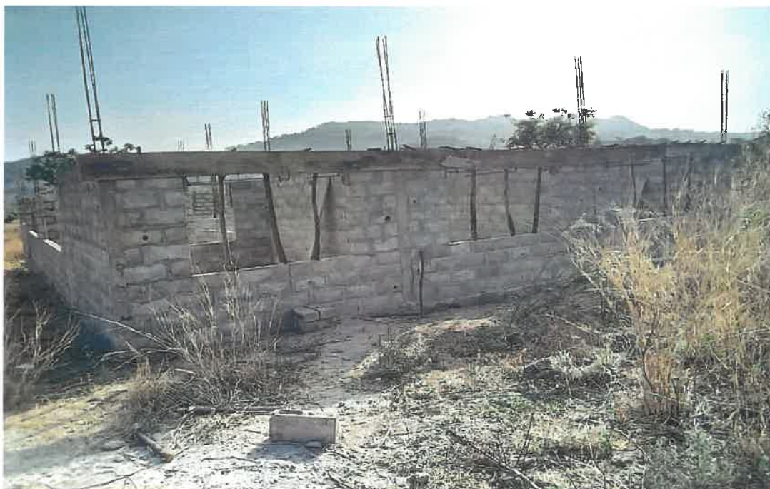
POLLAIO IN COSTRUZIONE
