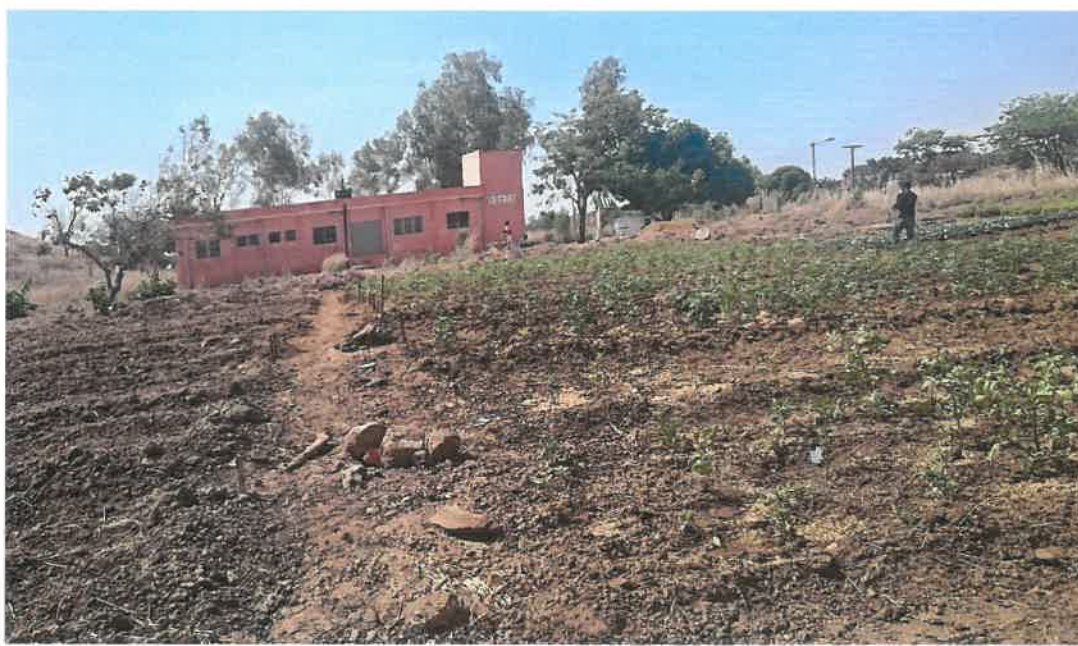
LA STRUTTURA DEL CENTRO POLIVALENTE
